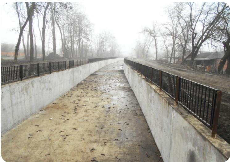
В первоочередной план работ по городской программе благоустройства внесены вопросы – максимально обеспечить жилой массив от водной стихии. В этих целях вдоль канала, протяженностью 3 км, ведутся усиленные работы. В настоящее время рабочие ведут реконструкцию мостов и бетонирование русла канала.
