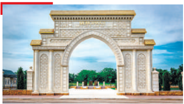
ДОГЦИЕНА ГӀУЛАКХ «ГӀоазот кашамашка» капитальни ремонт е лаьрхӀад
