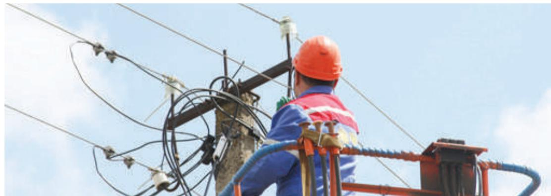
На участке протяженностью более 700 метров энергетики меняют оголенный провод на самонесущий изолированный (СИП), который имеет более высокий класс безопасности, устойчив к механическим повреждениям и неблагоприятным природным воздействиям, обладает высокими противопожарными свойствами. Применение СИП существенно сократит риск травматизма среди населения в случае нарушений правил электробезопасности и практически исключает несанкционированное подключение к сети.
