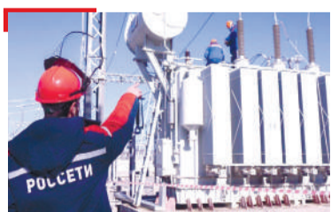
ГІАЛИЙ ТІАРА ХЪАЛ ГалгІайчен Шолжа- Шахъарá цъаькха трансформатор оттаергъа
