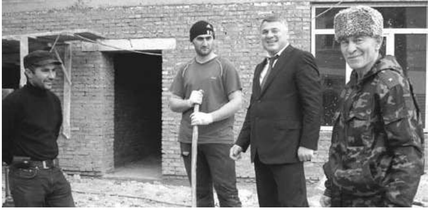
На строительном объекте: Али Султыгов считает самым главным в работе прямое общение с людьми
