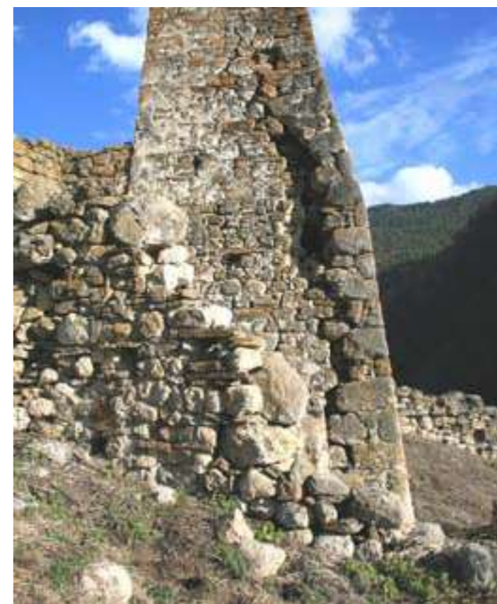
Боевая башня Хаьни. XIII век. До реставрации
