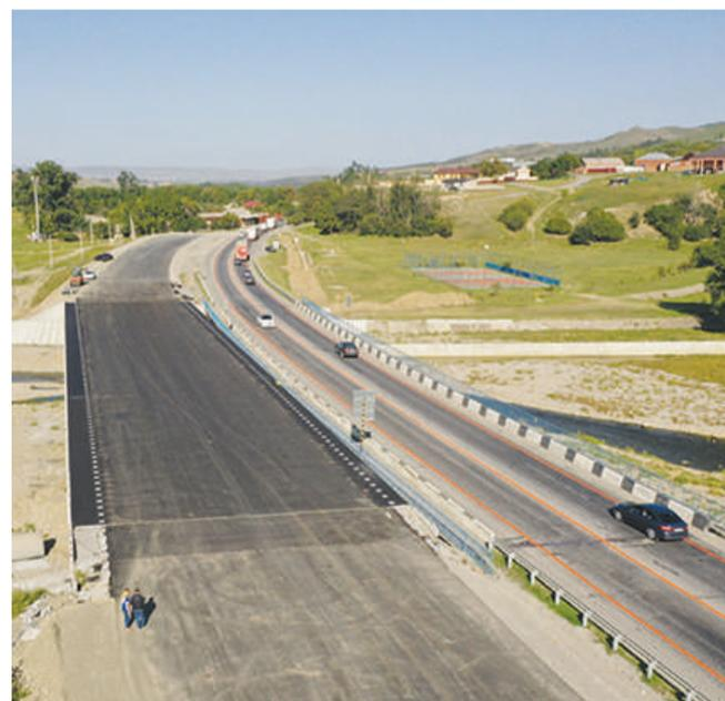
В ходе реконструкции рабочие мостоотряда отремонтируют опоры, а также усилят пролетное строение путем устройства монолитной железобетонной плиты и нового мостового полотна. Весь комплекс работ планируется завершить до конца 2020 года.
