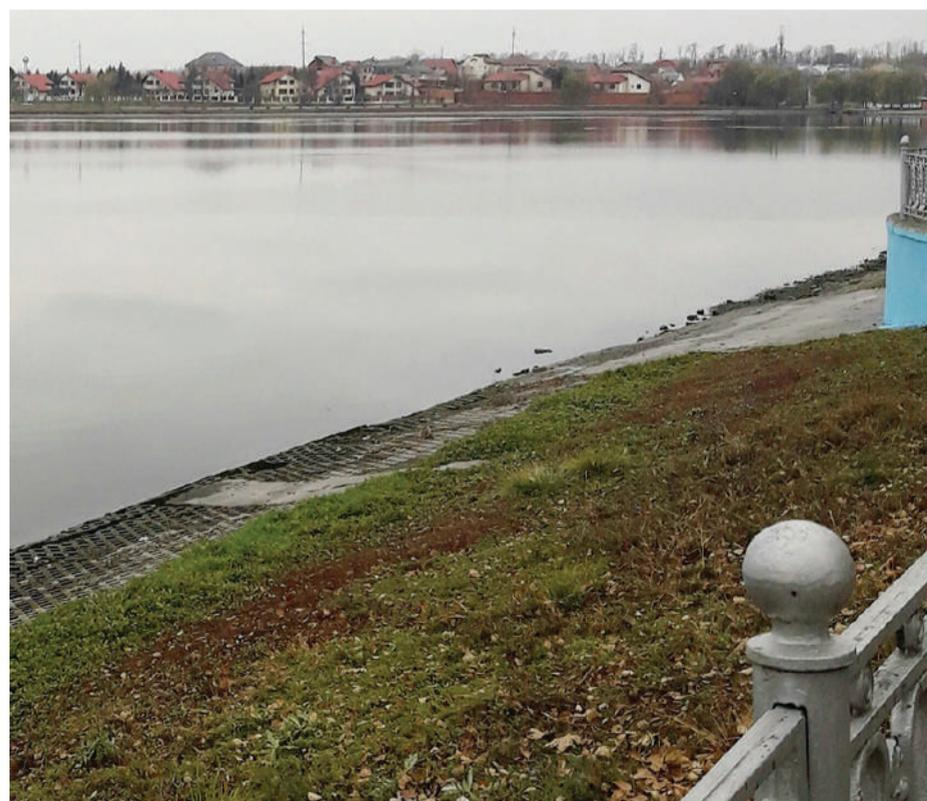
это время было вывезено более 200 тысяч кубометров донных отложений и установлена георешетка на берегах, проведена расчистка ложа водоема от илистого грунта, выполнено выполаживание надводных откосов и закреплена береговая полоса геосинтетическими материалами, закрепление и защита береговой полосы с помощью посадки многолетних трав.
