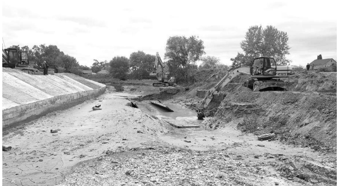
Работы на объекте начаты чуть меньше месяца назад. Строители подготовили площадку, выровняли русло на протяжении трехсот метров, установили буронабивные сваи, завезли арматурные металлоконструкции и мощные мостовые пролеты. Параллельно ведутся работы по очистке русла и берегокреплению, по шестьдесят метров по каждому бере-
